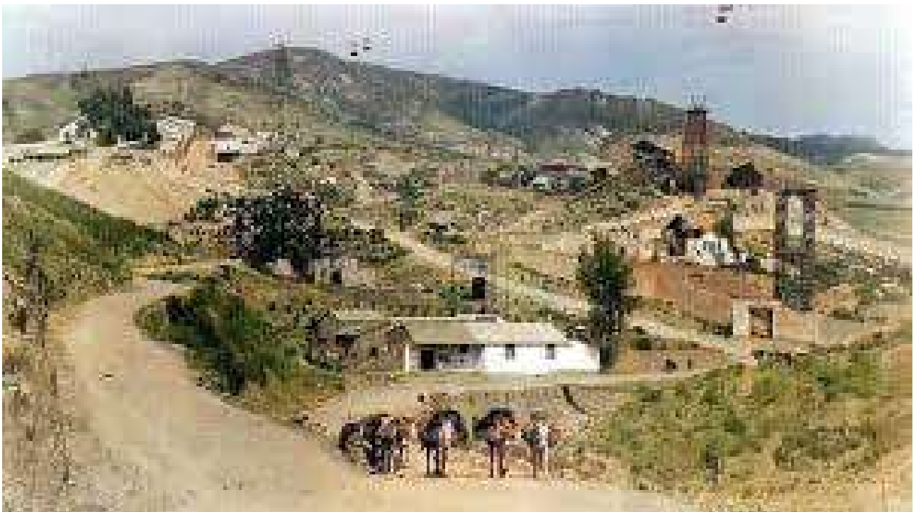
VISTA DEL BORDO HACIA LA MINA
